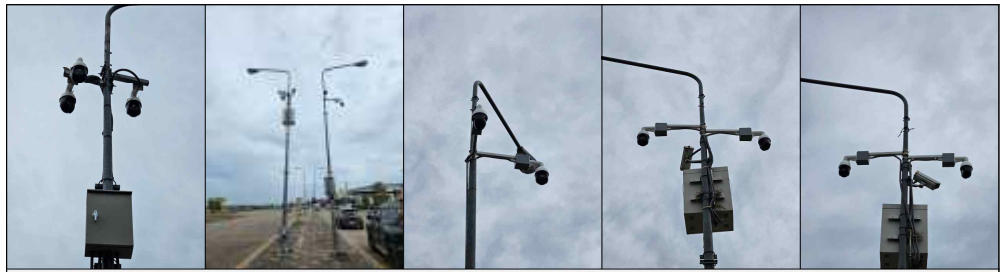
위치 별 CCTV 구축 확인 (1번 ~ 5번) * 지점별 PTZ카메라 2대씩 설치됨
